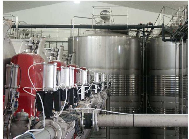
Fig. 13: Prensas y depósitos de acero inoxidable de la bodega Cuatro Rayas. Fuente: Bodega Cuatro Rayas.
